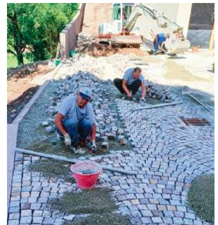
Pflasterarbeiten auf dem Pfarrplatz
