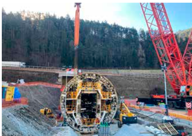
Teile der Tunnelbohrmaschine
