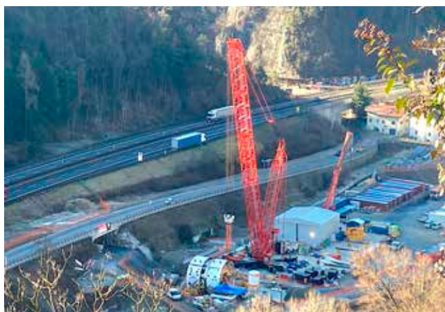
Baustelle Prader Areal
